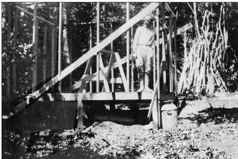
Георгий Гребенщиков на строительстве Чураевки. Возведение «Теремка». 1928 г. ГМИЛИКА
