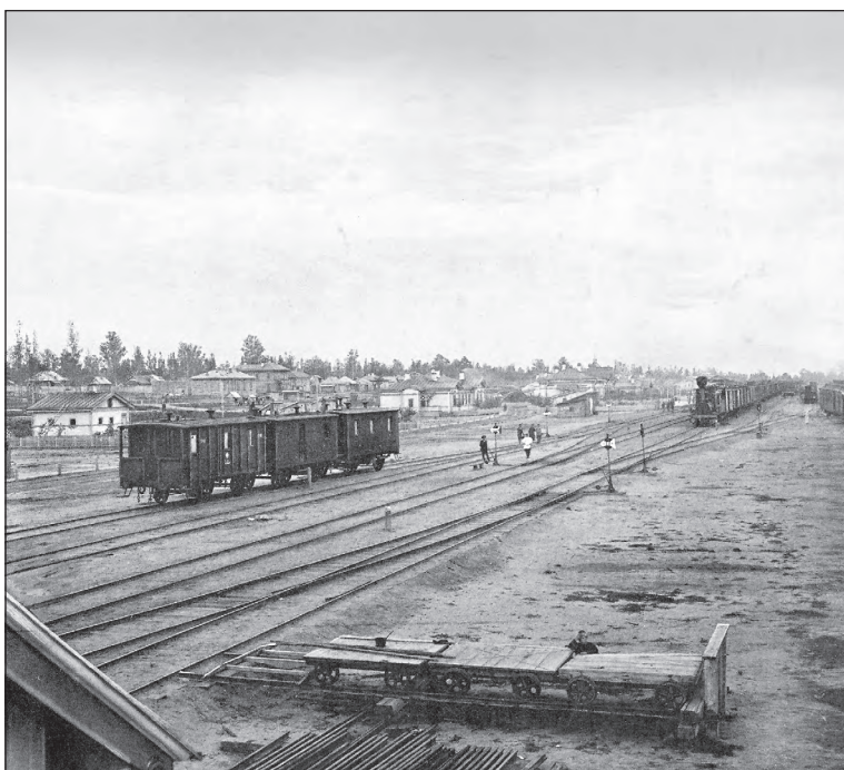
Общий вид станции Обь
