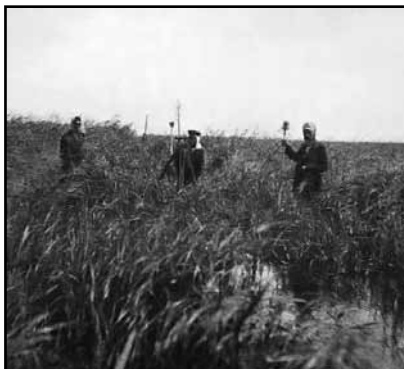
Работы по осушению Барабы: слева – нивелировка; справа – сооружение канала
